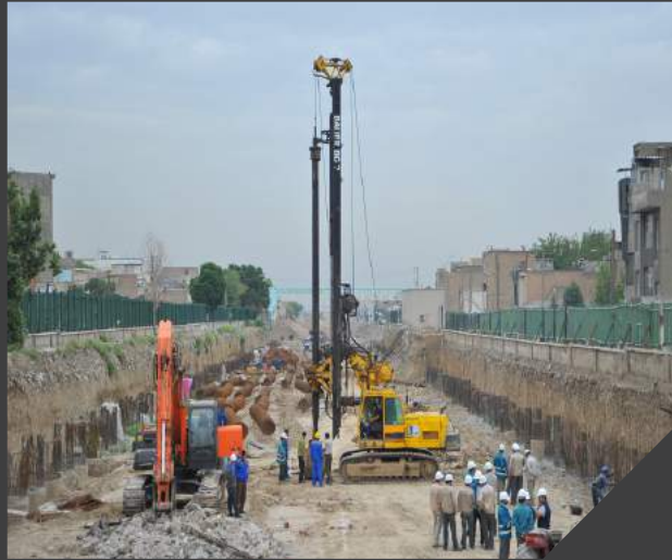
عملیات حفاری و پایلینگ
